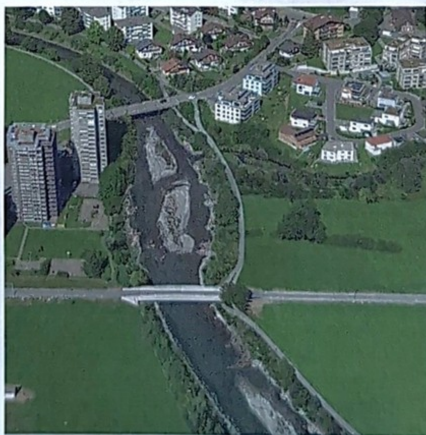
Kopfschütteln und Empörung: geplante Thursanierung.
